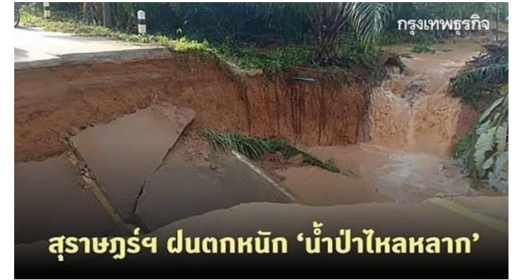
วันที่ 25 ต.ค. 63 น้ำป่าไหลหลากเข้าท่วมบ้านเรือนในหลายอำเภอที่เป็นพื้นที่เสี่ยงจังหวัดสุราษฎร์ธานี ระดับน้ำสูง 30-100 ซม.
