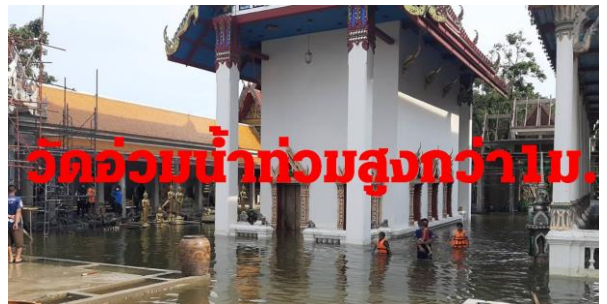
วันที่ 2 ก.ย. 64 เกิดฝนตกหนักทำให้น้ำท่วมถึงภายในโบสถ์และวิหารของวัดถึงแก่ว อ.บางพลี จ.สมุทรปราการ
