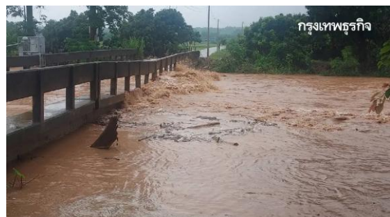
วันที่ 3 ก.ค. 68 เกิดฝนตกหนัก น้ำท่วมฉับพลัน และน้ำป่าไหลหลาก บริเวณสะพานบ้านม่วง-บ้านจิว อ.เชียงกลาง จ.น่าน
