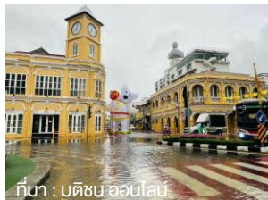
ที่มา : มติชน ออนไลน์ 22 ต.ค. 68 น้ำจากคลองบางใหญ่เริ่มท่วมเทศบาลนครภูเก็ต อ.เมือง และวันที่ 25 ต.ค. 68 เกิดน้ำหลากในพื้นที่ ต.ป่าตอง อ.กะงู จ.ภูเก็ต
